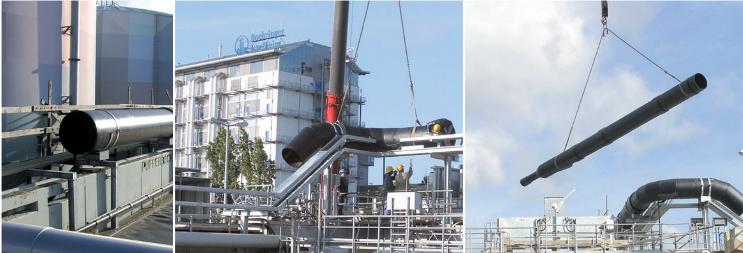
Auf einem Netz von Rohrbrücken finden die Rohre sicheren Halt. Zahlreiche Sonderbauteile ermöglichen eine individuelle Anpassung an die Gegebenheiten.
