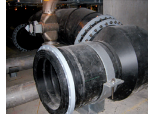
PE 100 Schweißkolonne da 900 mm SDR 17 inkl. verstärktem T-Stück PN 10.
