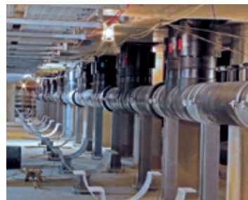
l: Zulaufleitungen aus SIMONA® PE 100 Großrohren; r. o. Brackwasserspeicherbecken mit PE 100 Zulauf da 1000/1200 mm; r. u. Aufgeständerte PE 100 Sammelleitung unterhalb der Filtrationsmodule
