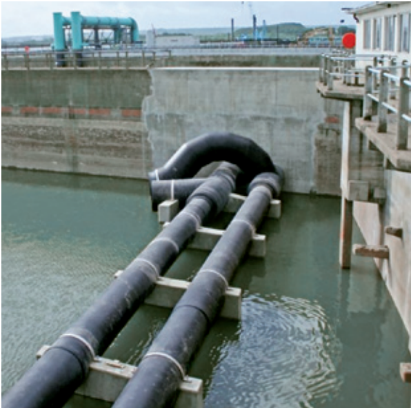
l: Zulaufleitungen aus SIMONA® PE 100 Großrohren; r. o. Brackwasserspeicherbecken mit PE 100 Zulauf da 1000/1200 mm; r. u. Aufgeständerte PE 100 Sammelleitung unterhalb der Filtrationsmodule
