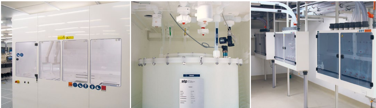
v.l.n.r.: automatische Nassprozessanlage; Innenansicht Chemieversorgungssystem; Verteilsysteme für Equipmentanschlüsse
