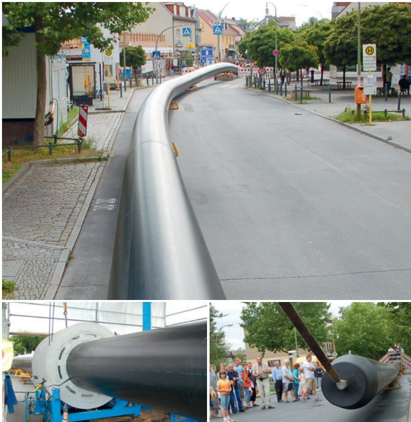
En haut : le tronçon de tube de 500 m de long a été inséré en une fois dans l'ancienne canalisation. En bas à gauche : les tronçons de tube sont été soudés les uns aux autres par polyfusion bout à bout aux éléments thermiques, avec emboîtement et verrouillage automatique pour résister aux contraintes longitudinales. En bas à droite : l'ensemble du tronçon de tube a pu être transporté sur le chantier de départ au moyen d'un équipement de chantier léger.
