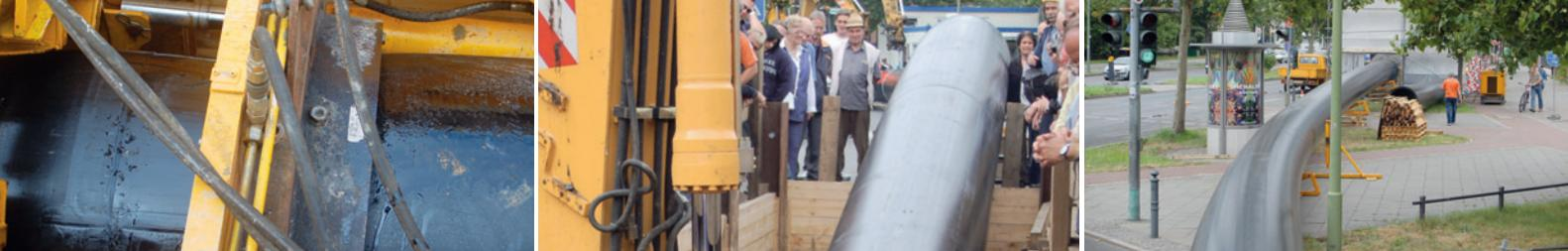
III. de g. à dr. : l'outil de réduction a permis de réduire le diamètre du tube SIMONA® PE 100 de 1060 mm à env. 970 mm. La petite taille des chantiers de départ et d'arrivée limite les nuisances pour les riverains et le trafic. La grande flexibilité des tubes SIMONA® PE 100 a également permis de réaliser des rayons de courbure serrés.
