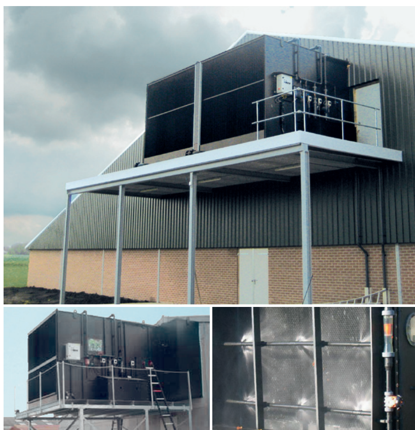
Boven en linksonder: open Nitro-Airwasser van KWB in Nederland; Rechtsonder: Nitro-Airwasser in werking
