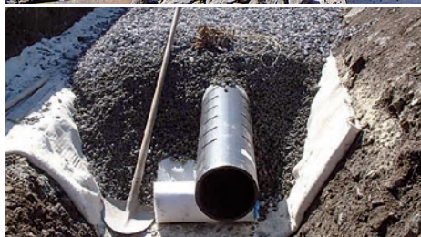
Nahoře: otevřený trativod s trubkami SIMODRAIN®, které jsou ze 2/3 štěrbínově perforované, poblíž trati Dole: Vložení šterkového filtračního lože geotextilií
