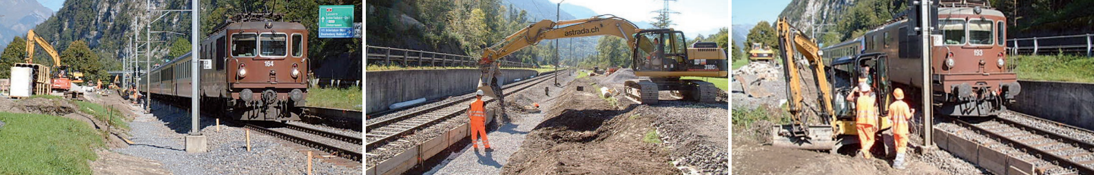
Obrázky zleva doprava: úprava staveniště a sklad potrubí poblíž trati; standardní pokládka potrubí do trativodu; stísněný prostor u trati za plného železničního provozu během stavební fáze vyžadovalo maximum spolehlivosti a přesnosti
