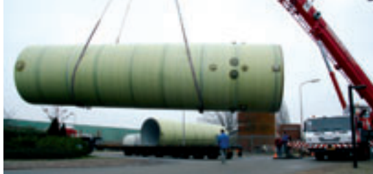
Abb. v.l.n.r.: Blick in die untere Röhre mit Gaseintritt, Transport der SIMONA® E-CTFE-GK/GFK Verbundröhren, SIMONA® E-CTFE-GK/GFK/Stahl fertig für den Transport
