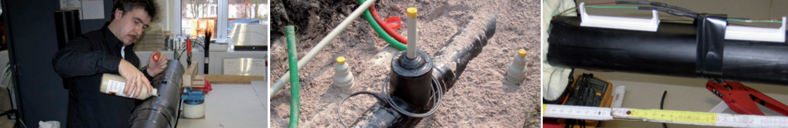
Abb. v.l.n.r.: Intensive Schulungen im Vorfeld sichern eine hohe Verarbeitungsqualität auf der Baustelle. Anschlüsse von Warm- und Kaltwasserleitungen. Integrierte Überwachungssysteme warnen bei gefährlichen Leckagen.
