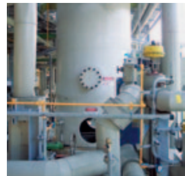
Rundbehälter aus SIMONA® PVC-C CORZAN Industrial Grade
