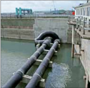
Deniz suyu tuz giderme tesisinin boru hatları
