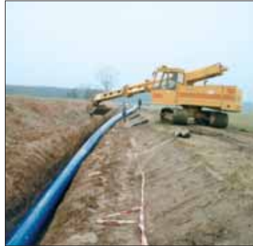
Kum yataksız döşeme için içme suyu hattı
