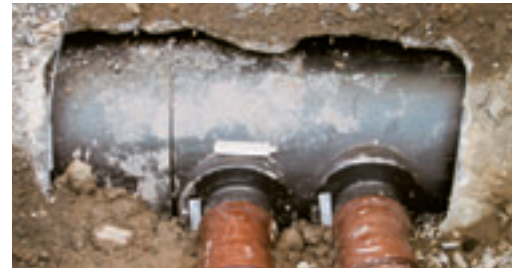
Anwendungsfoto: Hausanschluss-Außensattel
