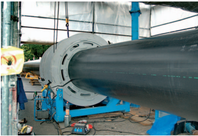
Bild 2: Mittels Heizelementstumpfschweißen wurden die beiden Rohrstränge stoff- und längskraftschlüssig miteinander verbunden
