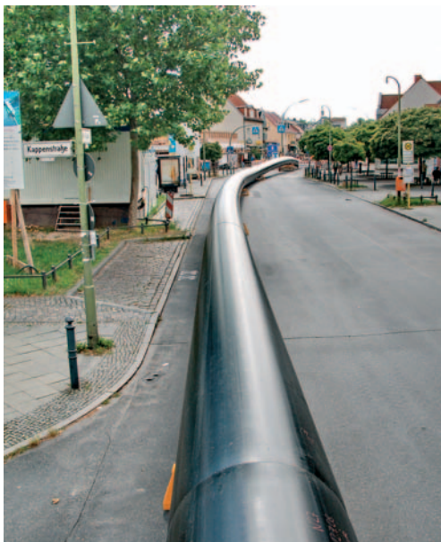
Bild 4: Der gesamte Rohrstrang wurde in einem Einzug in das Altrohr eingezogen
