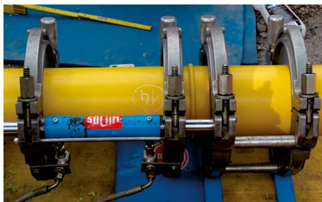
Svařování plynového potrubí z materiálu SIMONA® PA 12
