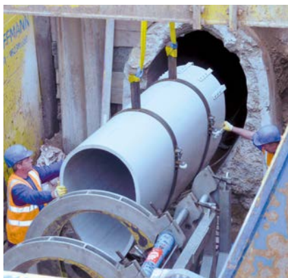
Sanace odpadního kanálu světlými vejčitými profily SIMONA® PE 100
