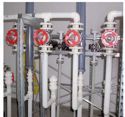
Tubes et raccords SIMONA® PVDF dans une installation de fluoration de l'eau
