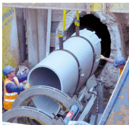
Assainissement d'une canalisation d'eaux usées avec des profilés de section ovoïde en SIMONA® PE 100 gris clair
