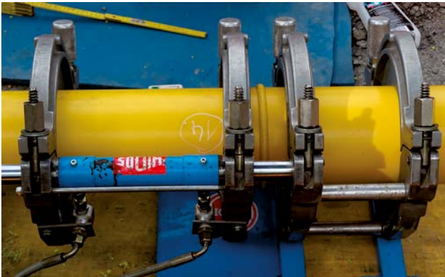
Soudage d'une conduite de gaz SIMONA® PA 12
