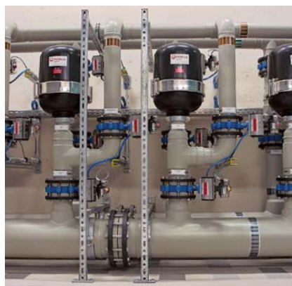
Installation de filtrage d'eau brute pour le traitement de l'eau en tubes et raccords SIMONA® PP-H AlphaPlus®
