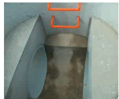
Blick in den Betonschacht mit SIMONA® PE Schachtanschluss SIMOFUSE® Typ C
