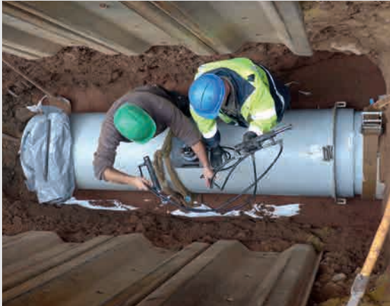
Offene Rohrverlegung mit Sandbett und Verbau-elementen (PE 100 grau/UV-stabilisiert; d 710 mm, SDR 17,6)
