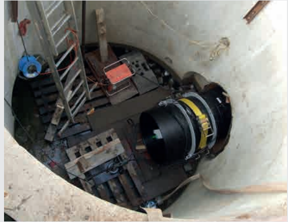
Sanierung im Kurzrohrrelining über Schachtbauwerk (PE 100; d 800 mm, SDR 17, Modullänge 700 mm)
