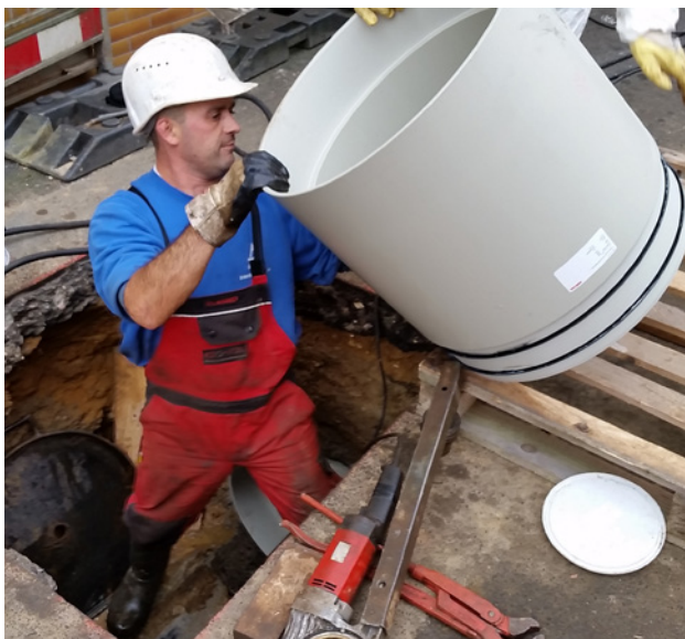
Bild 1: Montage der SIMONA® PP RM Vortriebsrohre durch einen Mitarbeiter der Firma karo-san
