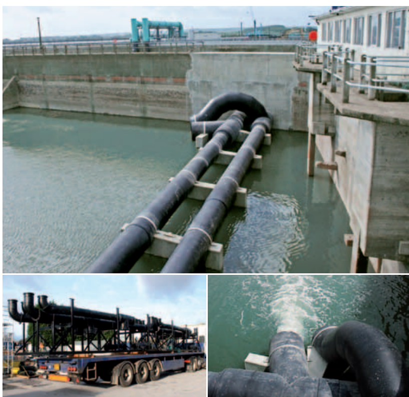
Grandes tubos de entrada de SIMONA® PE 100; Columnas soldadas de PE 100 prefabricadas; Estanque de almacenamiento de aguas salobres con tubo de entrada de PE 100 de 1.000/1.200 mm de diámetro
