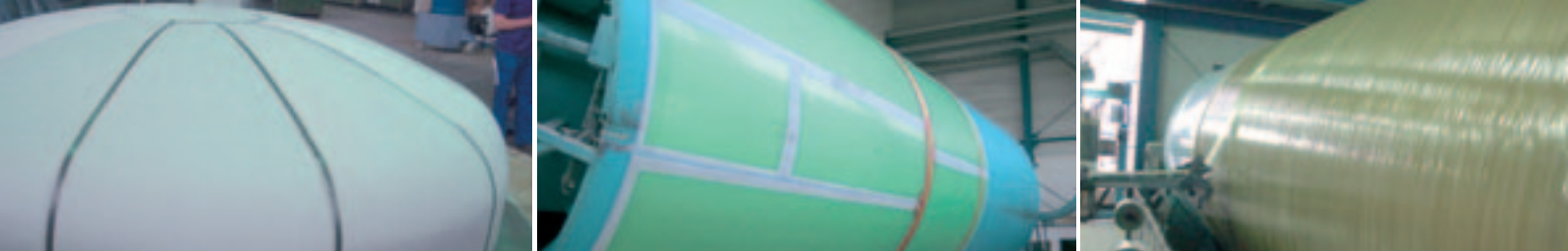
III. de gauche à droite : fabrication du fond bombé en construction segmentée ; cylindre en plaques SIMONA® PVDF-GK soudées ; bobinage du cylindre avec du plastique renforcé à la fibre de verre sur le mandrin de bobinage
