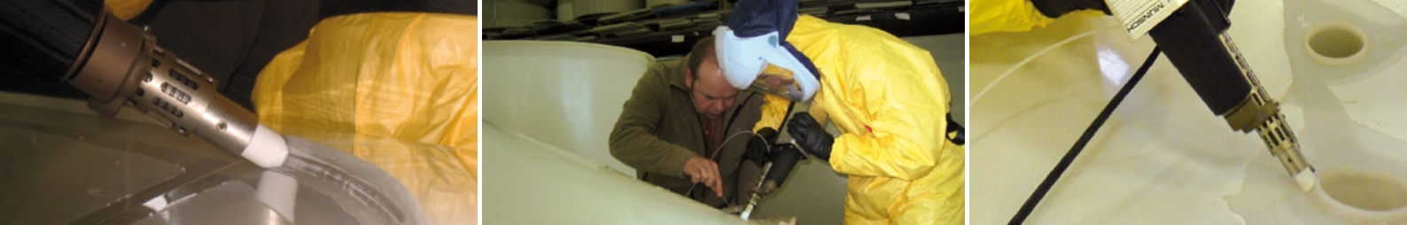
de g. à dr. : Travaux de soudage sur les semi-produits
