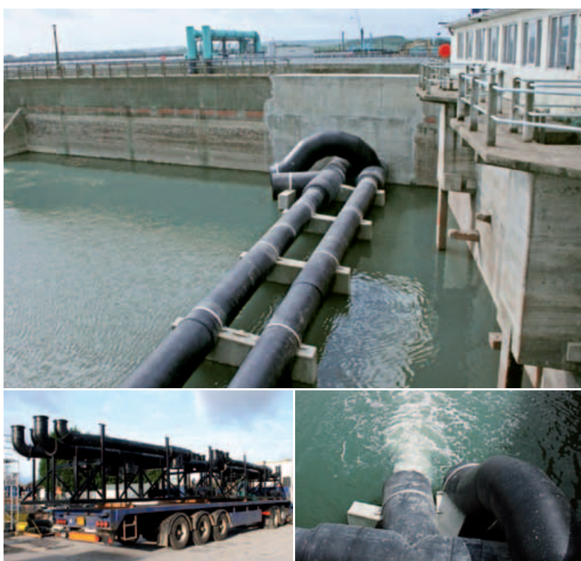
Conduites d'amenée en tubes de grande taille en SIMONA® PE 100 ; Colonnes de soudage en PE 100, préfabriquées en usine ; Bassin de retenue d'eau saumâtre avec conduite d'amenée en PE 100 (da 1000/1200 mm)
