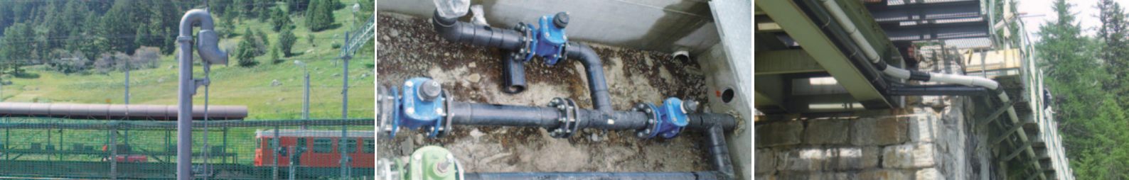
De g. à dr. : Construction d'une nouvelle grue hydraulique pour l'alimentation des locomotives ; Puits de distribution où convergent les conduites d'alimentation en SIMONA® PE 100 ; Conduites pour le transport de l'eau et la commande des sprinklers
