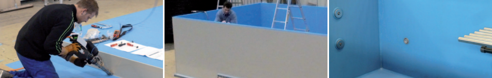
De g. à dr. : préparation du fond mis en place ; fixation des parois latérales ; montage des buses, des spots et des vannes
