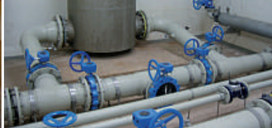
Abb. v.l.n.r.: Korrodierte Fugen des gefliesten Behälters; PP-H 100 AlphaPlus Rohrsystem in der Vorkammer; Pumpensumpf mit Entnahmesieher
