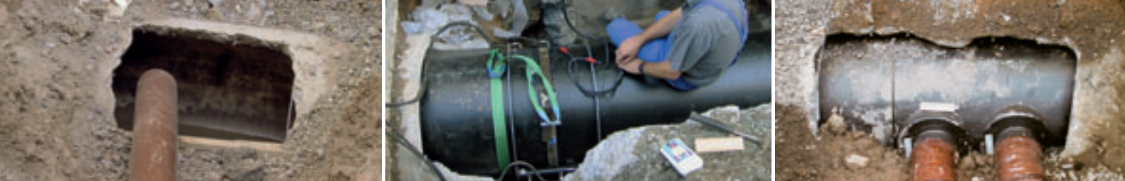
Abb. v.l.n.r.: Aufbruch der Betonrohrleitung im Bereich für die Erstellung der zukünftigen Hausanschlusszuläufe, Verbindung der Rohrmodule mittels Heizwendelschweißung, SIMONA® PE 80 Außensattel SIMOFUSE® verschweißt mit PE 100 Rohrmodul SIMOFUSE® und PVC-KG Rohr mittels Steckmuffenverbindung
