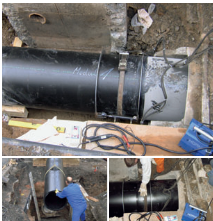
Sanierung einer defekten Stahlbetonrohrleitung mit SIMONA® PE 100 Rohrmodulen SIMOFUSE® mit integrierten Heizwendeln. Oben: die Verschweißung der Rohrmodule mittels Heizwendelschweißung. Unten: Das Einbringen der Rohrmodule in die Baugrube und das Altrohr.
