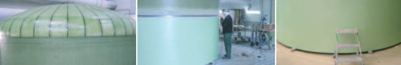
Abb. v.l. n. r.: Behälterdeckel, Fertigung des zylindrischen Teils, Behälterboden
