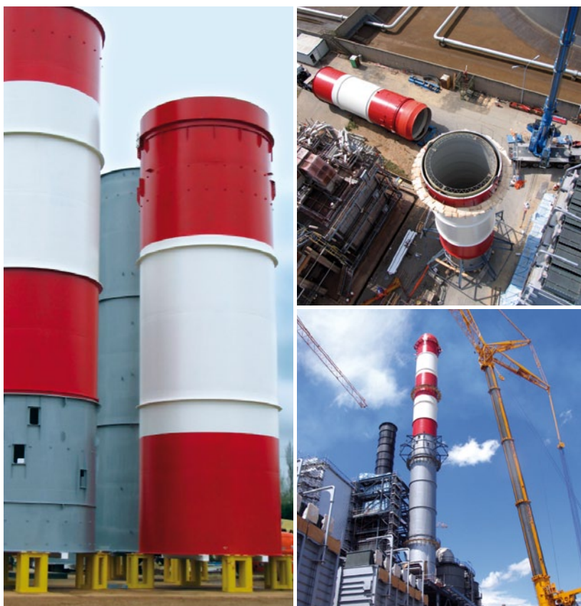
Links: SIMONA® E-CTFE-GK/GFK/Stahl vor Ort. Oben rechts: Vor der Montage des letzten Teils des Schornsteins. Unten rechts: Fertig montierter Kamin.
