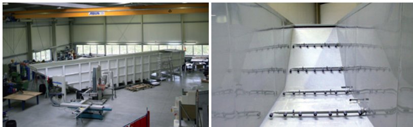
Oben: Stahlwanne beim Verladen. Unten: Beginn der Auskleidung mit SIMONA® PP-DWU AlphaPlus. Stahlwanne mit SIMONA® PP-DWU AlphaPlus Inliner.
