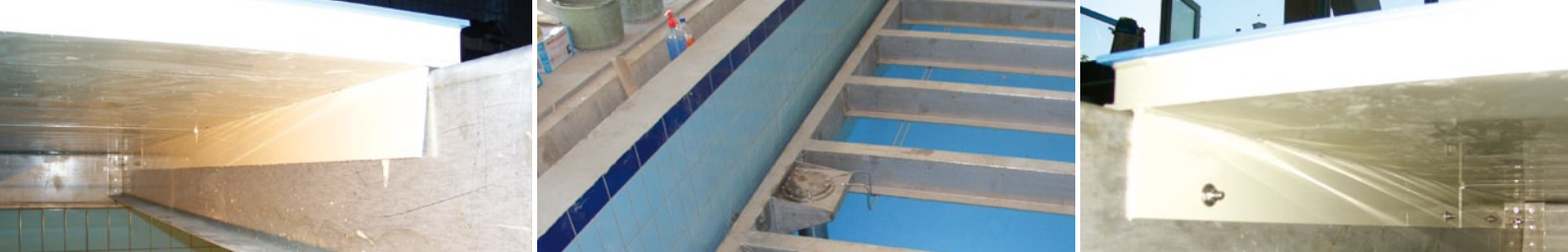
v.l.n.r.: mit Befestigungsplatten verschweißter Schwimmbeckenboden, Stahlgerüst zur Hydraulik, verschraubter Schwimmbeckenboden.
