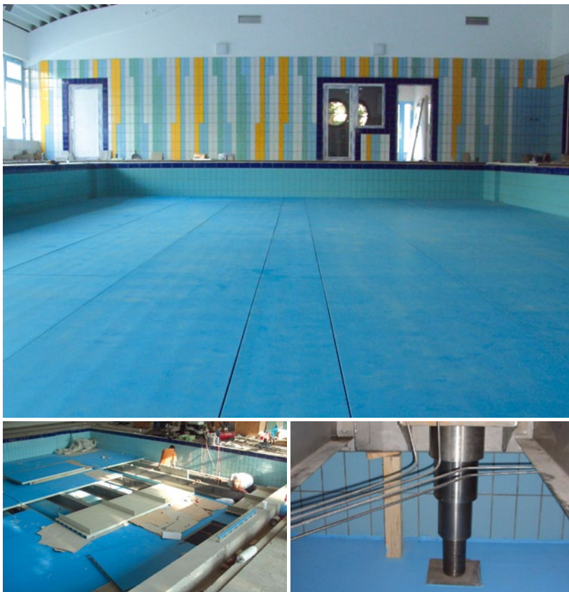
Oben: Beckenboden des Lehrschwimmbeckens. Unten: Montage des Beckenbodens. Hydraulik zur Einstellung unterschiedlicher Wassertiefen.
