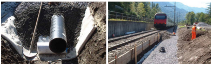
Oben: Offener Sickergraben mit 2/3 geschlitztem SIMODRAIN® Rohr, neben der Trasse; Unten: Ummantelung der Filterkiespackung mit einem Geotextil
