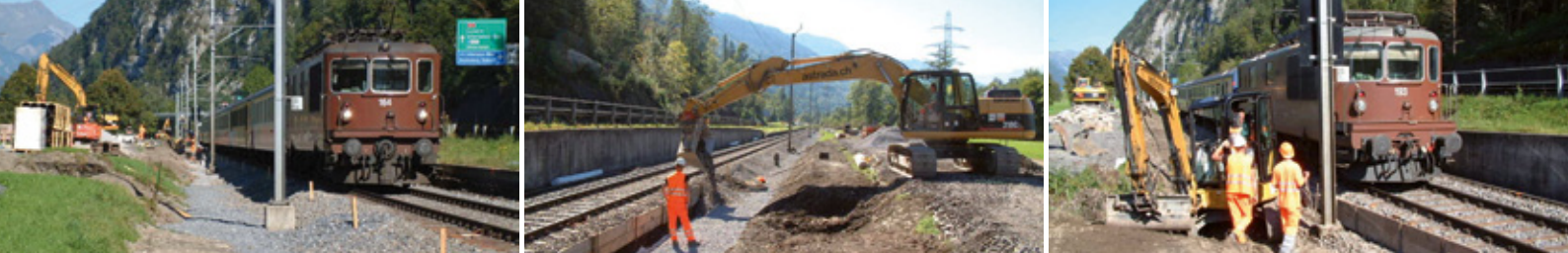
v.l.n.r.: Baustelleneinrichtung und Rohrlagerplatz neben der befahrenen Eisenbahntrasse; normgerechter Einbau im Sickergraben; beengte Platzverhältnisse und Vollbetrieb während der Bauphase forderten höchste Zuverlässigkeit und Präzision
