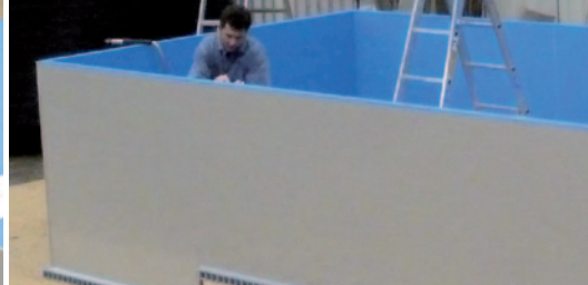
v.l.n.r.: Verarbeitung des abgesetzten Bodens; Befestigung der Seitenwände; Einbau der Düsen, Spots und Armaturen
