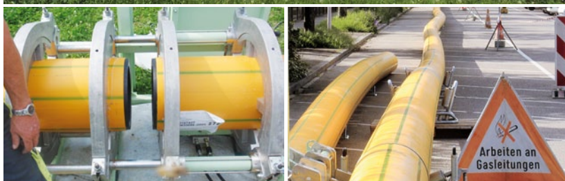
Oben: Anlieferung der SIMONA® SPC RC-Line Druckrohre, 20 m Stangenlänge; unten links: Stumpfschweißung der Schutzmantelrohre; unten rechts: vorgeschweißter Rohrstrang für den Rohreinzug
