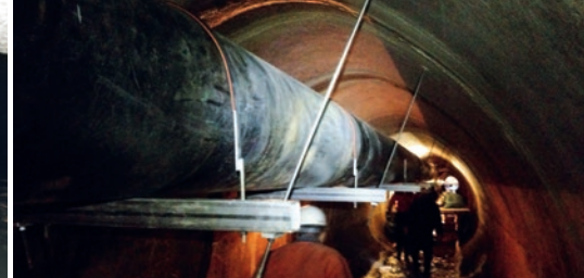
v.l.n.r.: Lagerung der SIMOFUSE® Rohre; Spezialhalterungen und Auflager für die SIMOFUSE® Rohre; abgehängtes Rohr im Ei-Profil-Kanal
