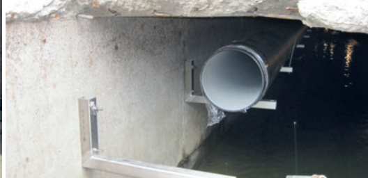
v.l.n.r.: Lagerung der SIMOFUSE® Rohre; Spezialhalterungen und Auflager für die SIMOFUSE® Rohre; abgehängtes Rohr im Ei-Profil-Kanal
