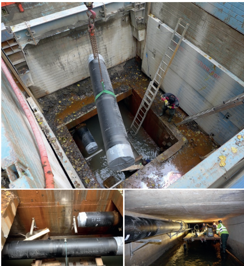
Oben: Abteufen der SIMOFUSE® Rohrmodule über das Einstiegsbauwerk; unten links: Transport der Rohrmodule auf eigens dafür gebauten Rollenwagen; unten rechts: Montage der SIMOFUSE® Druckrohrleitung im unterirdischen Bachprofil
