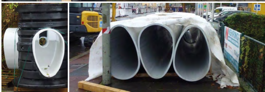
Oben: zwei verschweißte Eiprofil-Module mit aufgestecktem Muffenband; unten links: CoEx Schacht mit heller Innenschicht und Eiprofilanschluss; unten rechts: Lagerung der Eiprofile ohne Fuß auf der Baustelle
