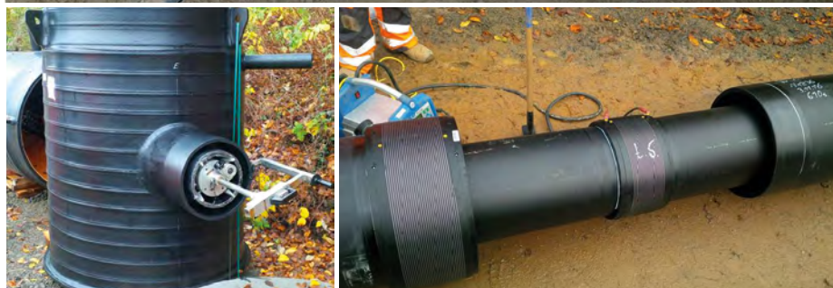
Oben: werkseitig vorgefertigter SIMONA® PE 100 Druckrohrleitungsschacht mit Doppelrohranschlüssen und Vorbereitung zur Aufnahme der Leckagemeldeinheit; unten links: Schälggerät aus dem SIMONA® Werkzeugmietpark; unten rechts: Kaskadenschweißen der SIMONA® Doppelrohrleitung d = 355/500 mm
