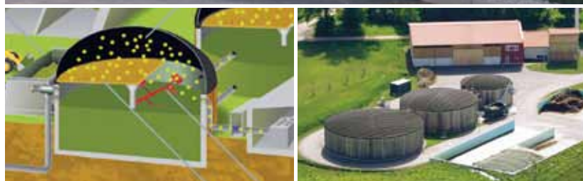
Nahoře: pohled na fermentory; dole vlevo: funkční schéma bioplynové stanice; dole vpravo: dokončená bioplynová stanice
