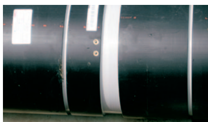
2. Einschub von Spitze in die Muffe auf einer zuvor vorbereiteten sauberen Unterlage.
