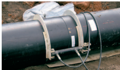
4. Zusammenführung der beiden Rohrenden mittels hydraulischer Kraftübertragung.
