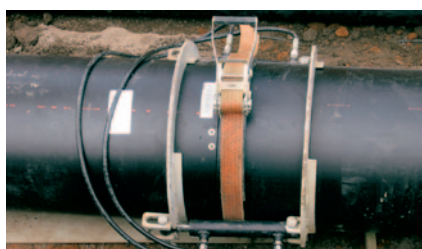
5. Montage Spannwerkzeug (hier Spanngurt) zur Minimierung des Spaltmaßes und Übertragung des erforderlichen Schweißdruckes.
