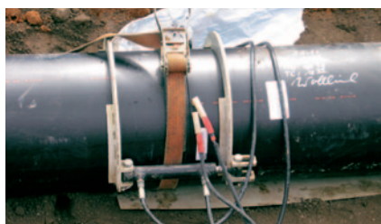
6. Anschluss 40-V-Universalschweißgerät für Elektroschweißmuffen an die vorhandenen 4 mm Anschlusskontakte.
