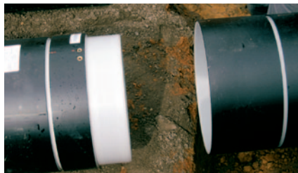
1. Fluchtgerechte Positionierung der Rohre.
