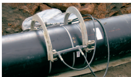
3. Justierung des hydraulischen Aufspannwerkzeuges. Spannschalen greifen in die dafür vorgesehenen Nuten.
