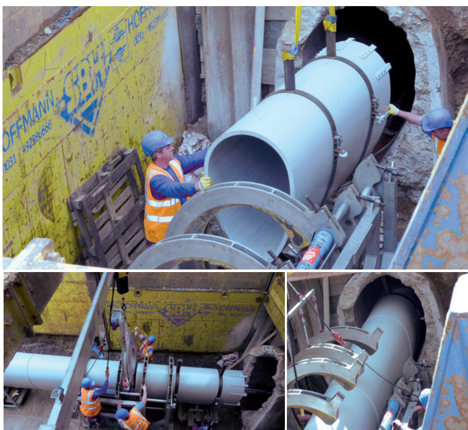
Nahoře: Zavádění tažné hlavy k navaření na vejčitý svařenec opatřený vymezovači Vlevo dole: Zavádění hoblíku a příprava ke svařování tažné hlavy a vejčitého profilu Vpravo dole: Zatahování vejčitého profilu
